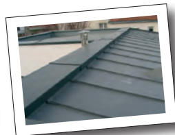
Pattes de couverture à joints debouts.
