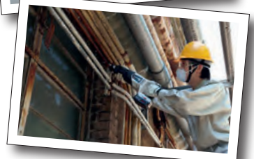
Travaux généraux. Montage en menuiserie.
