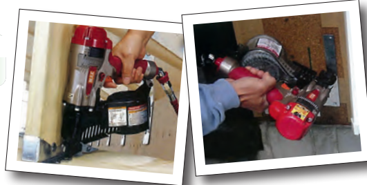
Fixation des sabots / connecteurs métalliques.
