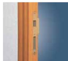
Travail frontal pour la gâche et les orifices du bec-de-cane et de la béquille.
