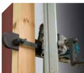
Coupe propre et précise permettant la fixation en un temps record du nouveau dormant sur l'ancien.
