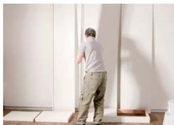
Placer le côté du meuble sur le socle. L'élément est directement positionné correctement grâce à la vis saillante
